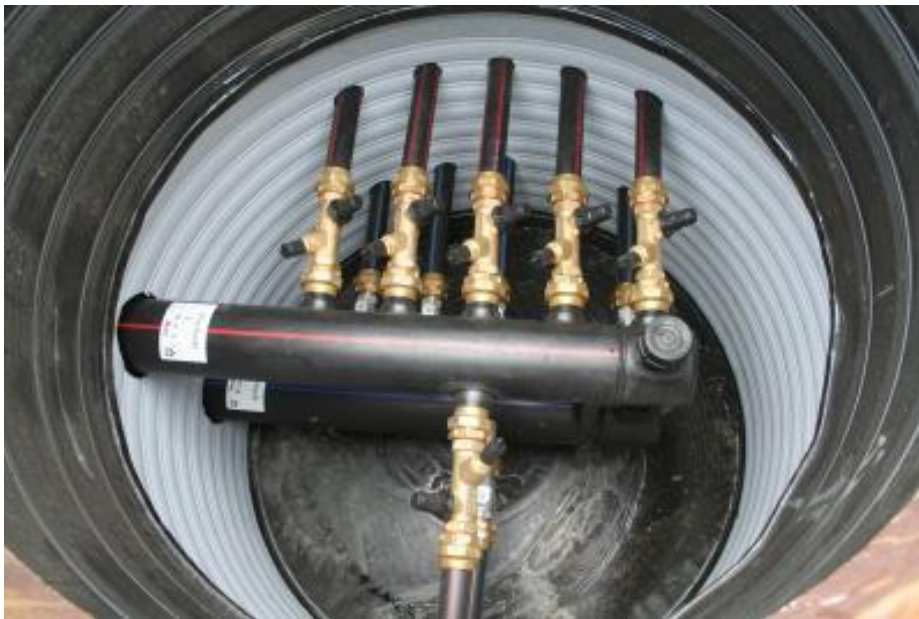
Figur 7 Et eksempel på samlingsbrønd for seks energibrønde.
