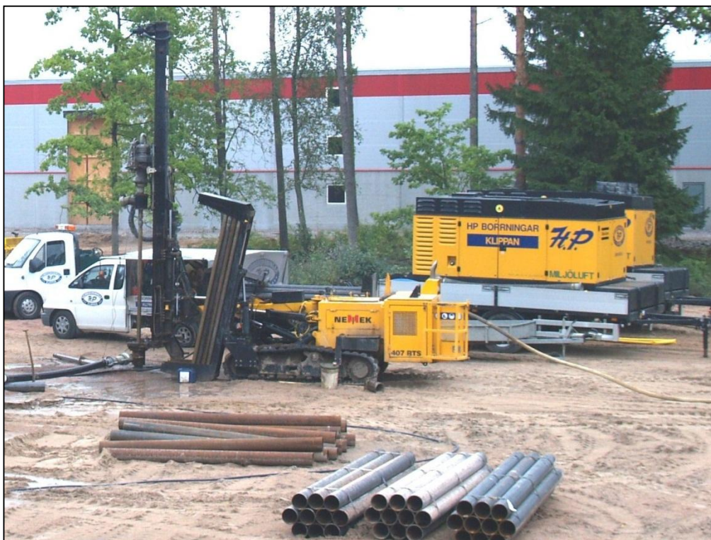
Figur 2 Boreriggen linet op til boring.
