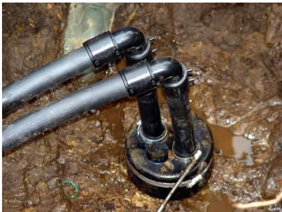
Figur 6 Installationen afsluttes med montering af tætsluttende låg, og kolektorslangerne svejses sammen med rørledningerne.
