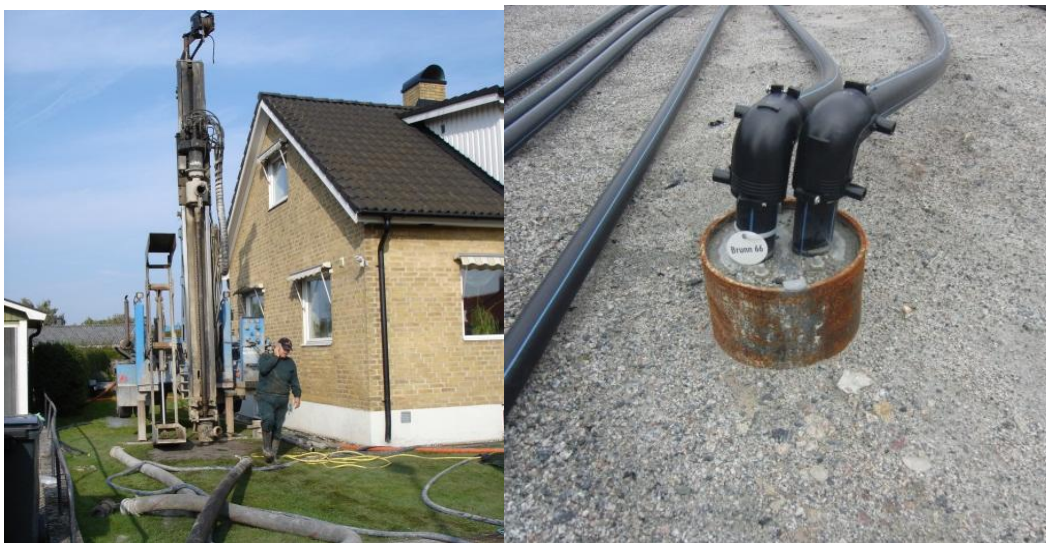
Figur 9. T.v. Boring af energibrønd til enfamilieshuse. T.h. Kollektor installeret i energibrønd.
